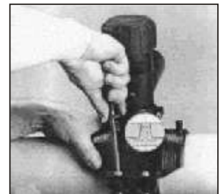
Slika 30. Postavljanje obujmice na cijev
